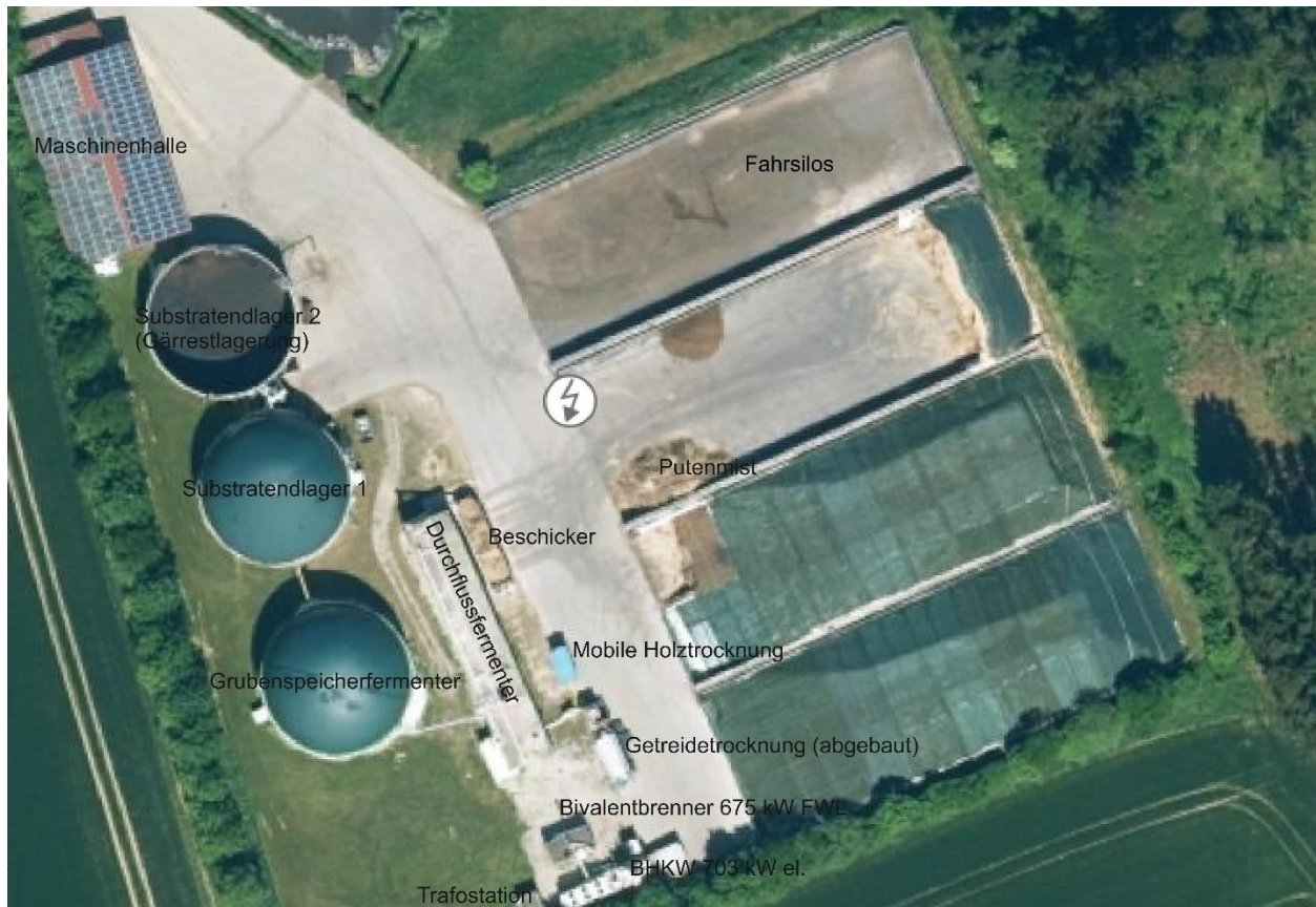
Abbildung 4: Gelände der Biogasanlage mit Beschriftung der Anlagengebäude und der relativen Lage auf dem Betriebsgelände. Quellenangabe Geobasisdaten: Bayerische Vermessungsverwaltung
