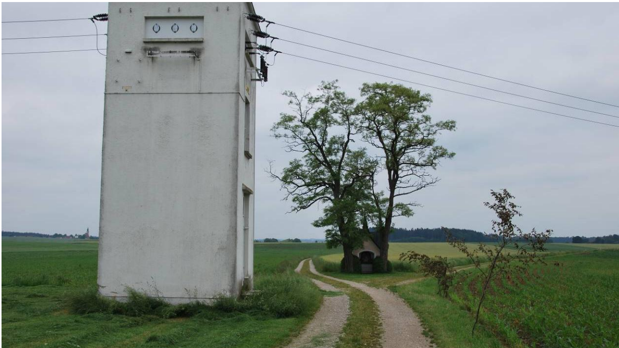
Abbildung 6 Etwa 100 m nordöstlich des Plangebiets, Blick Richtung Westen, mit Trafo-Turm und Feldkapelle umgeben von Robinien.
