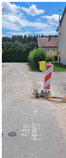
Bauarbeiten Glasfaserausbau in Oberbuch
