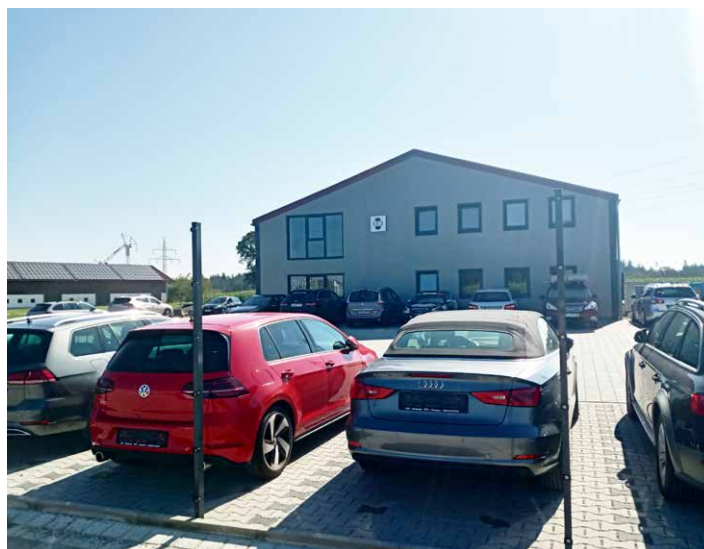
Das neue Werkstattgebäude mit Büro in Gigling
