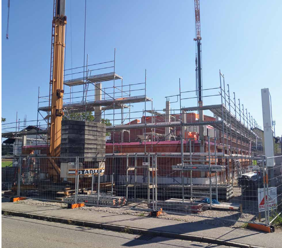
Baustelle Feuerwehrhausneubau in Feichten
