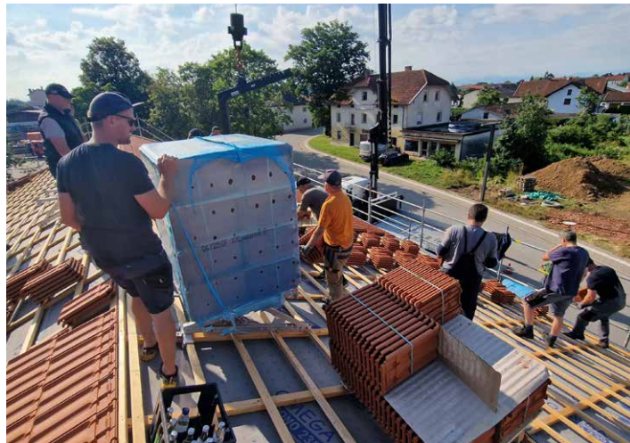
Viele Helfer beim Bau der neuen Halle
