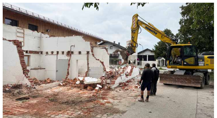
Abbrucharbeiten am Feuerwehrhaus
