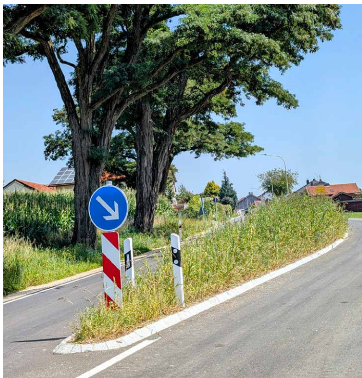
Der neue Fahrbahnteiler in Oberbuch
