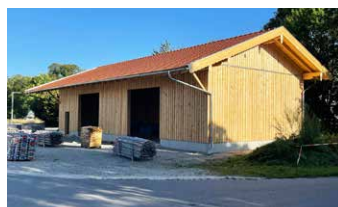
Neue Leonhardi-Halle am Bahnhof fertiggestellt
