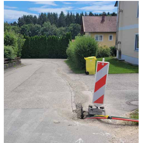
Arbeiten am Glasfasernetz
