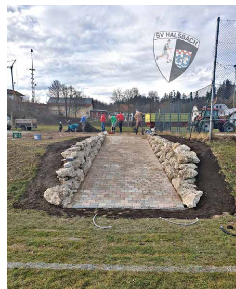
Halsbacher Sportplatzteam beim Bau der Rampe für den Mähroboter
