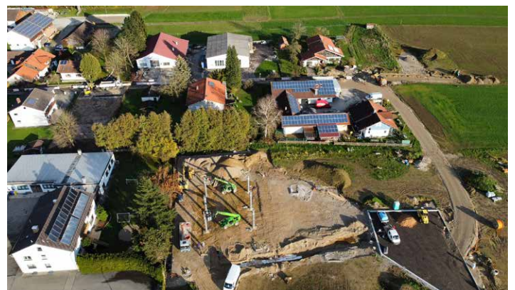
Baubeginn im neuen Baugebiet Auerstraße
