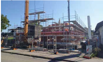
Neubau Feuerwehrhaus Feichten geht voran
