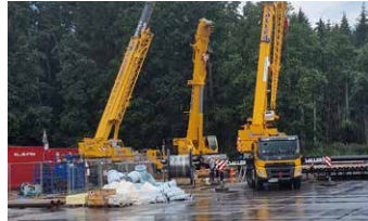
Fernwärme für Halsbach – wo wir derzeit stehen
